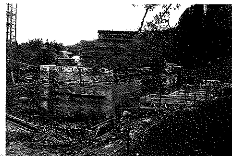
Les fondations du nouveau Grand-Hôtel sortent petit à petit de terre. Etat des travaux en juin 1984.
