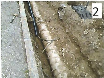
2. A l'époque, le câble électrique de commande du réservoir d'eau de Chaumont avait été enfoui tel quel, sans protection, le long de la conduite de gaz. Il y fallu l'isoler par un tube spécial.
